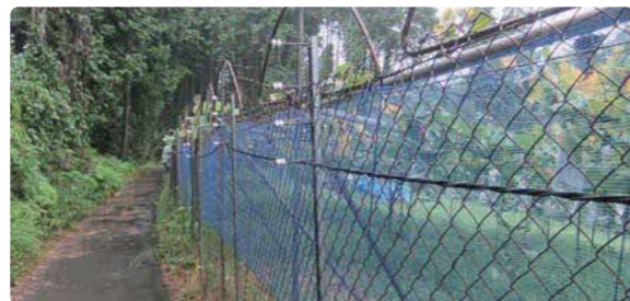
侵入防止柵の設置
